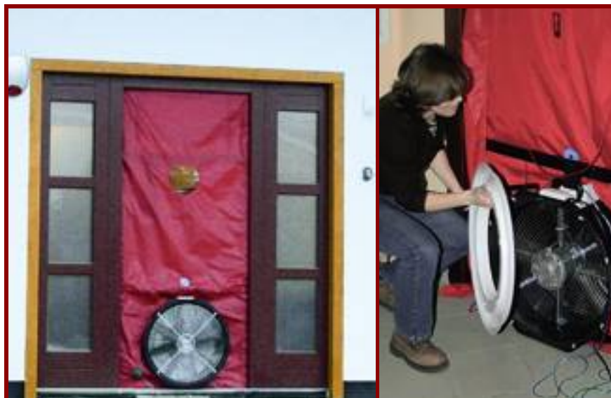
▲ Foto 5 - Il blower door test
