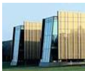
Foto 1 - Esempio di Edificio a basso consumo
